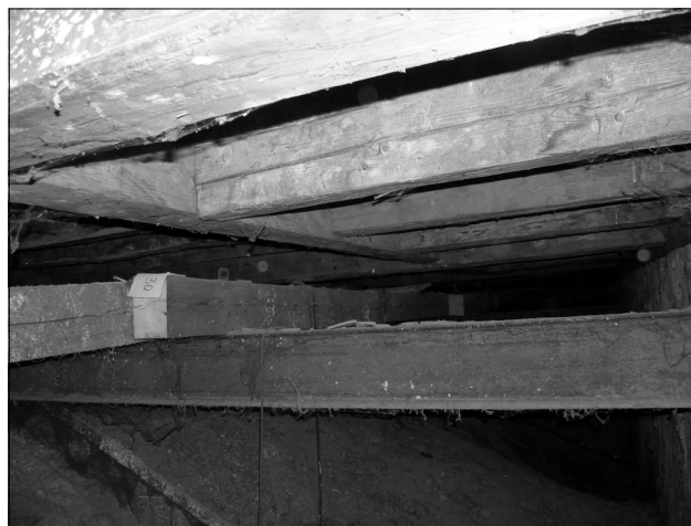
14. kép: a szentély boltozata feletti vonóvasakra fektetett fenyőgerendák (30. minta)
