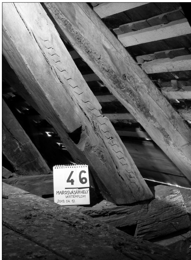
10. kép: szarufán megfigyelhető vésett vájat
