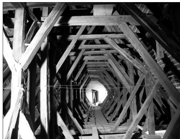
3. kép: a szentély feletti fedélszerkezet keletről
