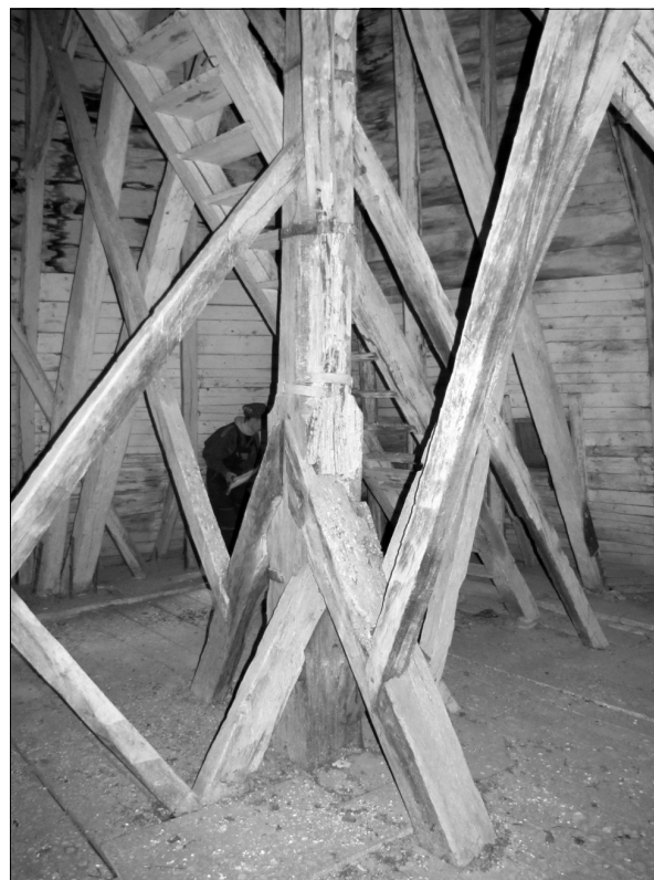
5. kép: a toronysisak szerkezete
