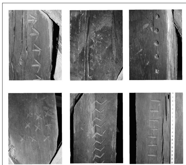
8. kép: a szentély feletti tölgyfa fedélszerkezet elemein látható ácsjelek
