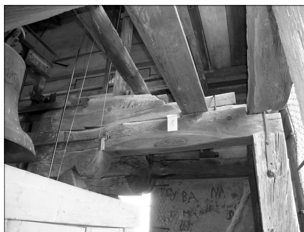
6. kép: a mai harangállás szerkezete (a 9. faminta helye)
