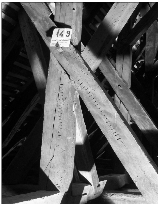
9. kép: ácsjelek a déli oszlopon és a hozzá kapcsolódó szögletkötőn a 19. állásban
