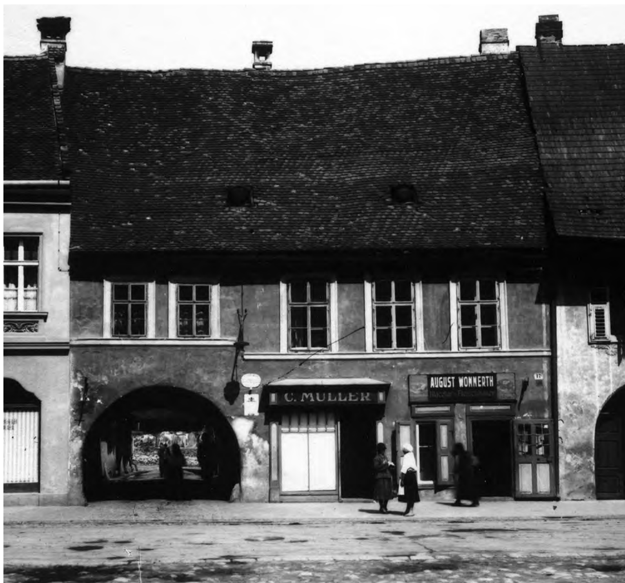
Fig. 27. Casa cu gangul carosabil. Fotografie de arhivă de la începutul secolului XX.
