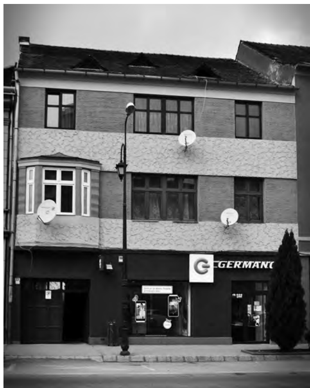
Fig. 55. Str. Baier nr. 23. Clădire funcționalistă din anii 1940.
