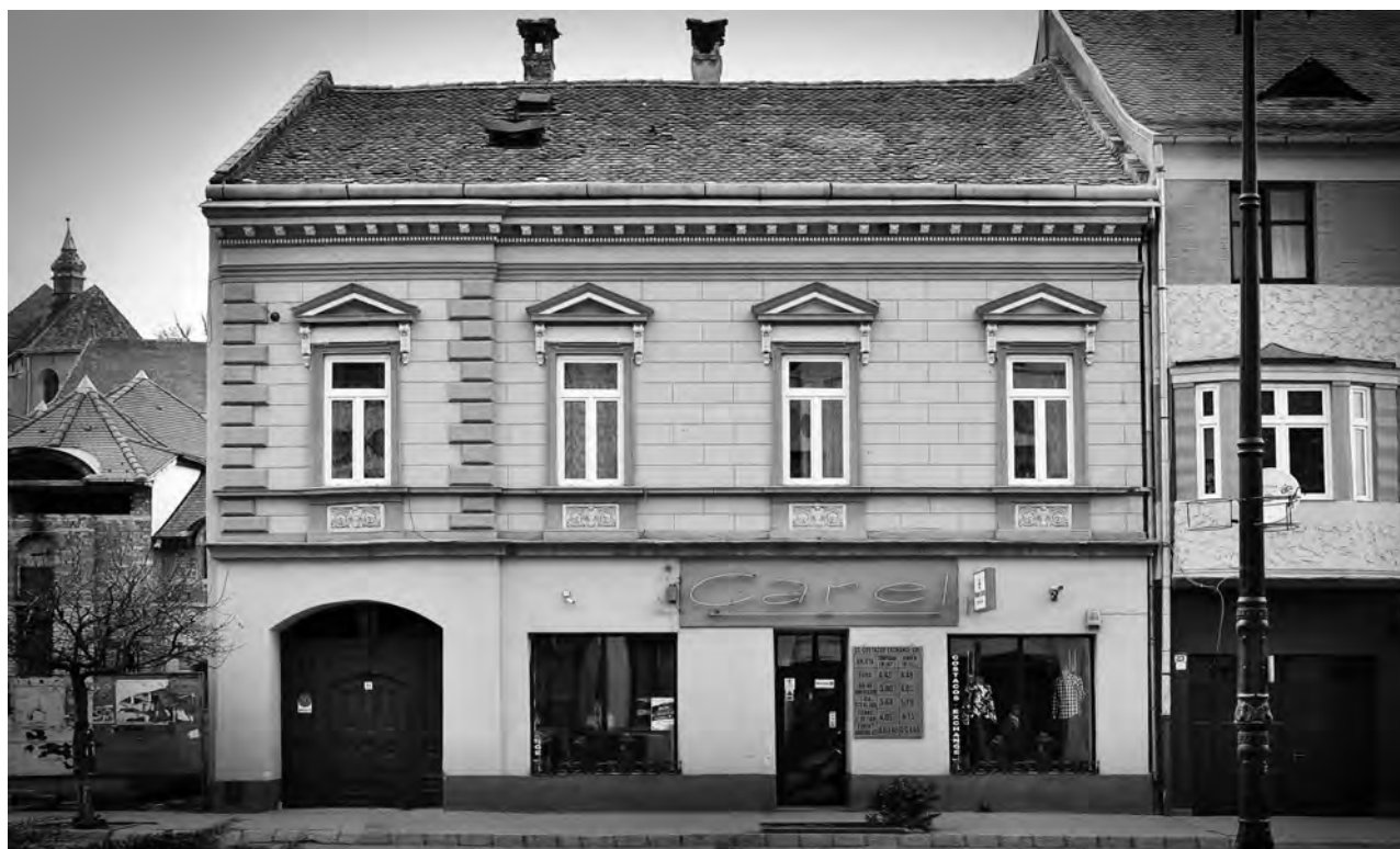
Fig. 48. Fațada casei cu nr. 21 de pe strada Baier.
