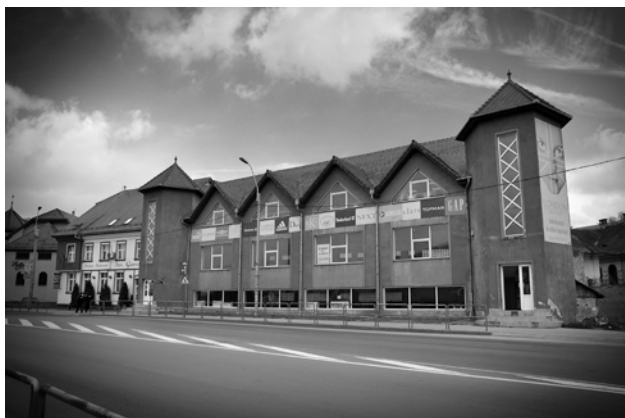
Fig. 64. Construcție aflată pe strada Consiliul Europei.
