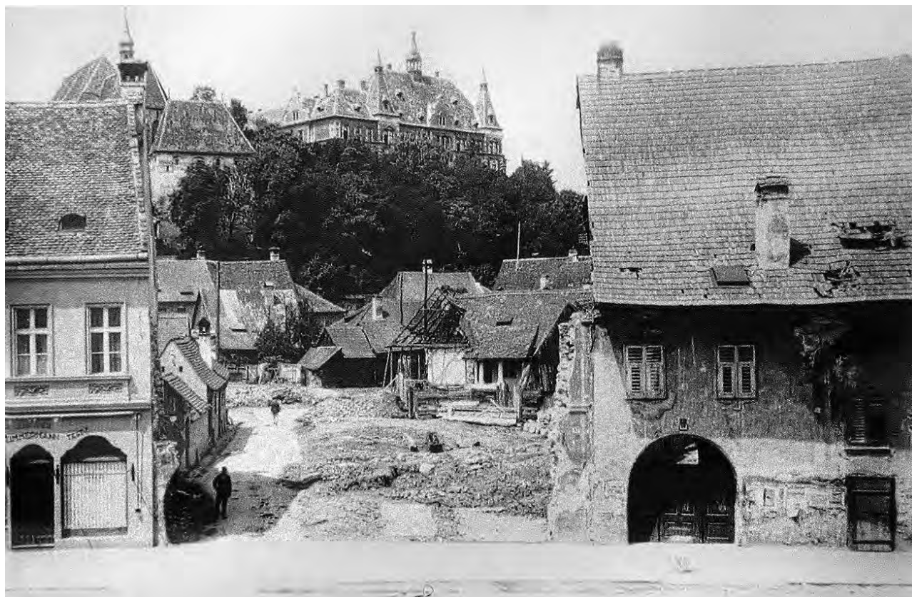
Fig. 11. Demolarea casei cu gangul carosabil (1928)
