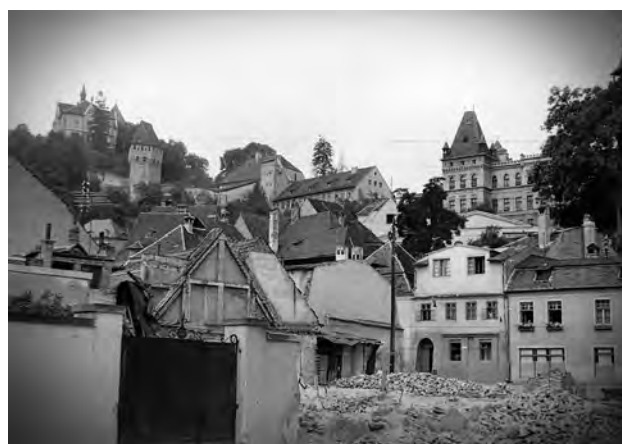
Fig. 14. Demolări de case executate la flancul sud-vestic al Pieței 23 August în anul 1963. Fotografie de Tamás Németh. Fortepan 30129.
