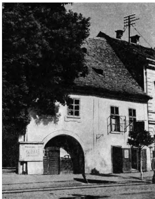
Fig. 35. Casă demolată în 1989 cu ocazia lărgirii racordului dintre strada Morii și Bulevardul 1 Decembrie 1918.
