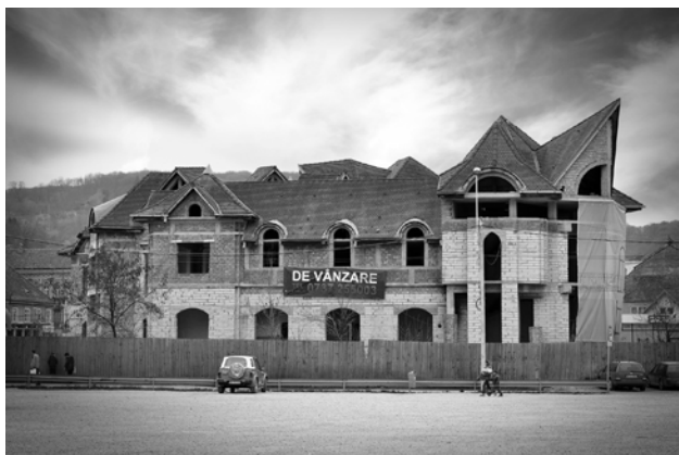
Fig. 62. Construcția nefinalizată a CEC-ului.
