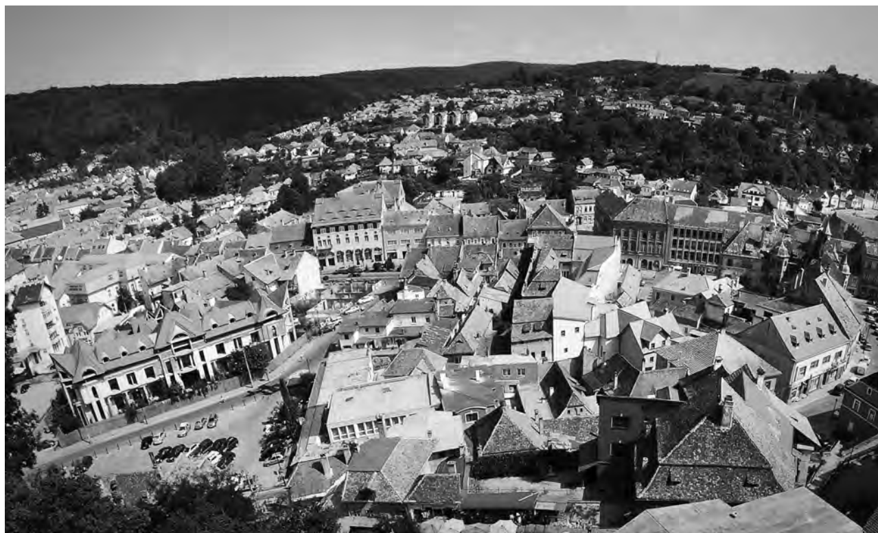
Fig. 20. Vedere de ansamblu a cvartalului cercetat. Fotografie realizată în anul 2008.
