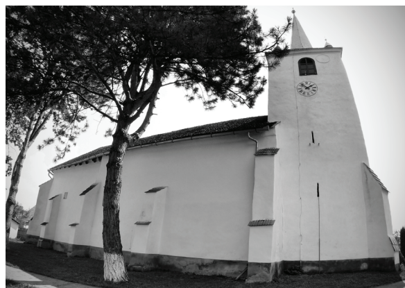
Fig. 8. Fațada de nord, detaliu cu porticul.
