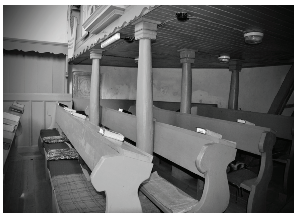
Fig. 29. Sistemul de susținere al corului de est.
