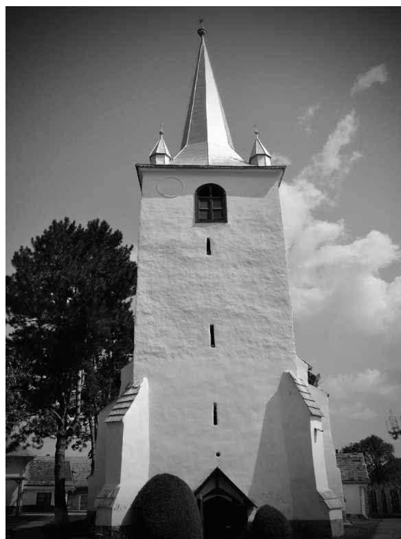
Fig. 6. Fațada de vest, situație actuală.
