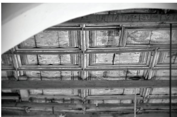
Fig. 25. Tavanul casetat al absidei, fragment cu consolidările ulterioare.
