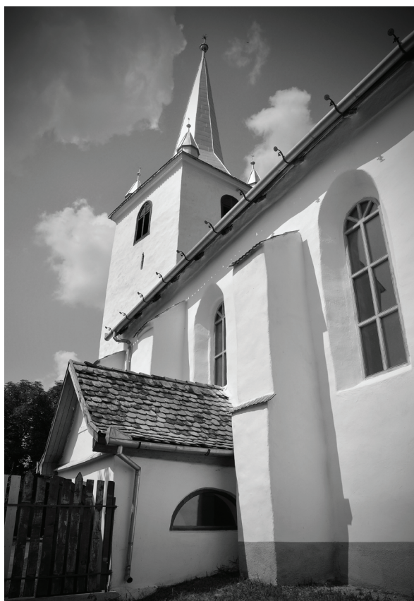
Fig. 7. Fațada de sud, detaliu zonă racord navă-absidă.
