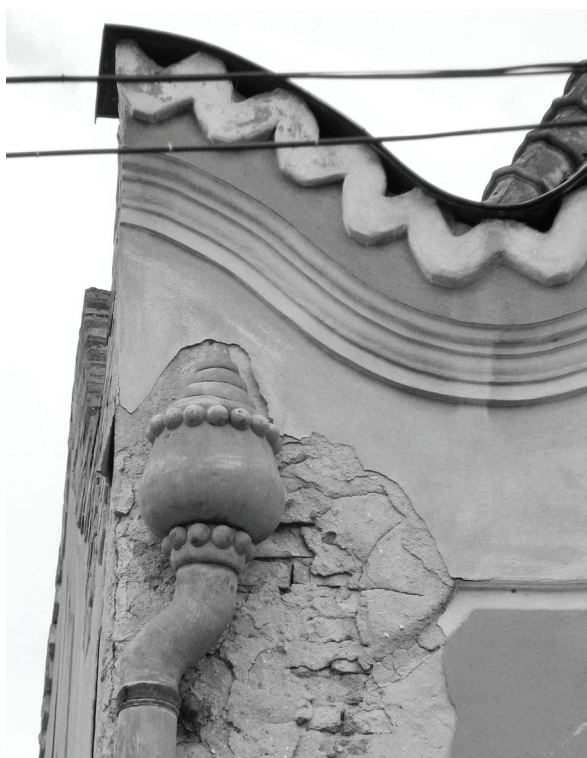
Fig. 18. Colectorul superior al burlanului (fotografia autorului, 2018).
