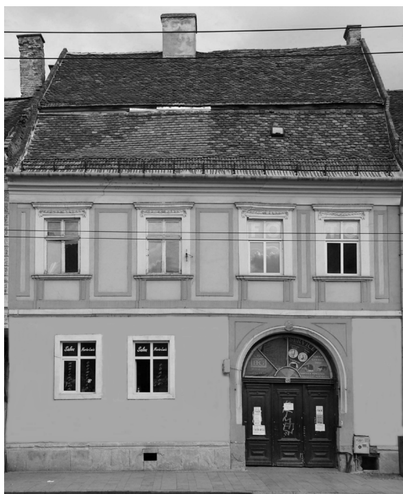
Fig. 3. Fațada principală a clădirii (foto Melinda Mihály, 2020)
